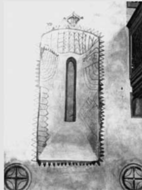
Frühgotisches Fenster mit Weihekreuzen an der Südwand der Kirche, von außen verdeckt durch einen Stützpfeiler.
