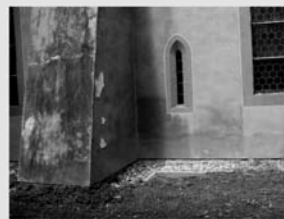
Eines der kleinen Schlitzfenster in der Südwand.
