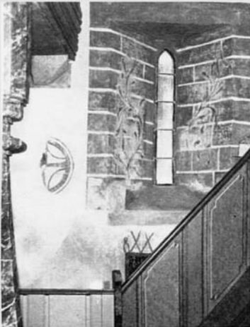
Frühgotisches Fenster an der Südwand der Kirche. Unterhalb des Fensters ist das nachträglich eingefügte Oberteil einer Sakralnische zu sehen, deren Überreste bei Renovierungsarbeiten gefunden wurden.
