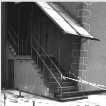
Treppenaufgang von außen zur Empore.
